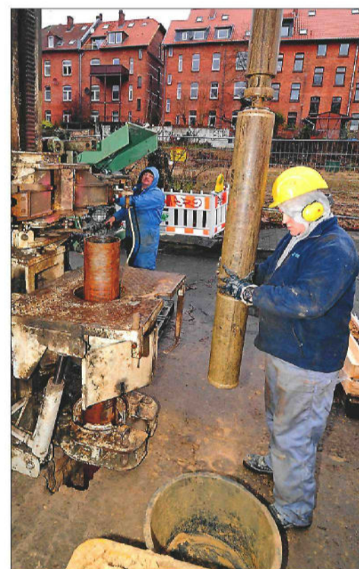
Thomas Bagan (r.) und Igor Münch übernehmen mit schwerem Gerät die Bohrung an der Frommestraße. In den vergangenen Jahren haben die Senkungen hier zugenommen. Foto: be
